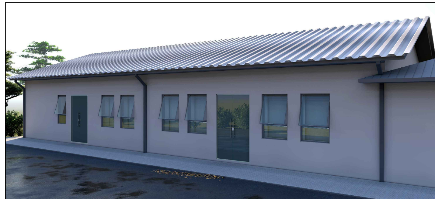
Vista lateral perspectiva 3D Cobertura telha sanduiche
