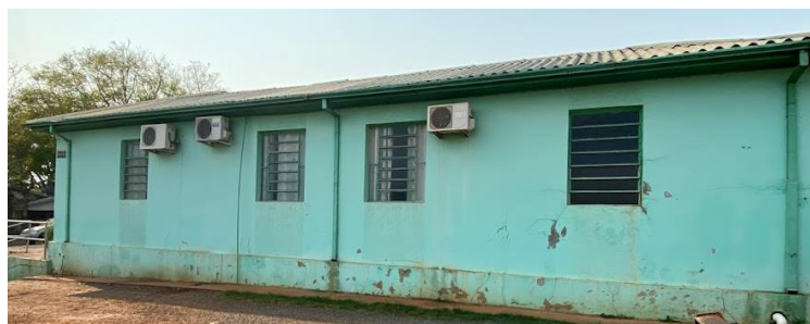
Figura 17: Fachada lateral. Fonte: Acervo da autora.
