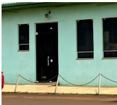
Figura 03: Rampa a ser removida.
